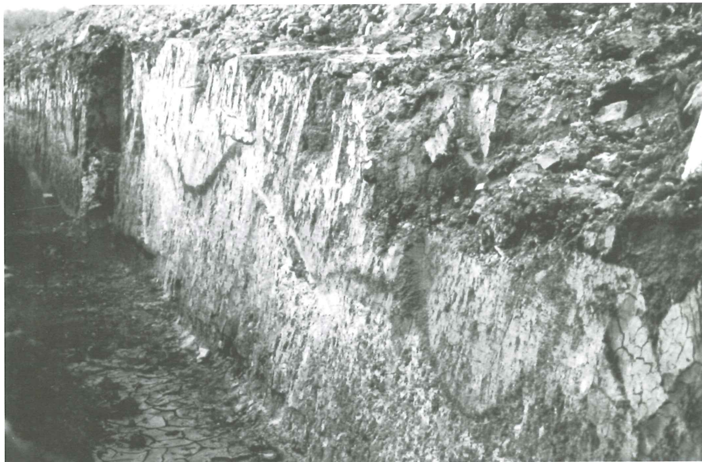
Fig. 28. Trincea dell'Acquedotto di Romagna. La sezione nei pressi di Castiglione.
