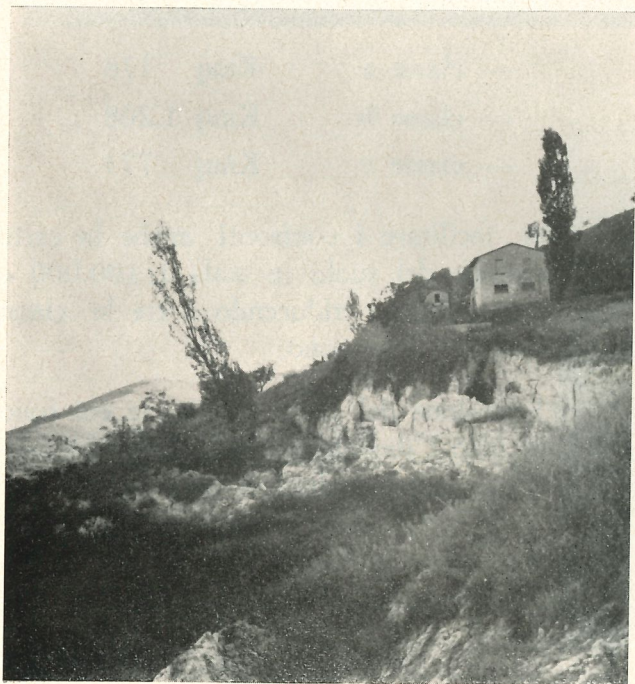
Fig. 52 - Frana nelle molasse. Zona del torrente Voltre (F. Bidente-Ronco).
