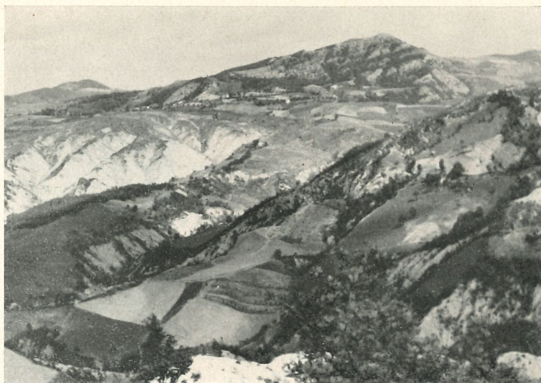
Fig. 51 - Erosione e dissesto nella zona del passo del Carnaio.
